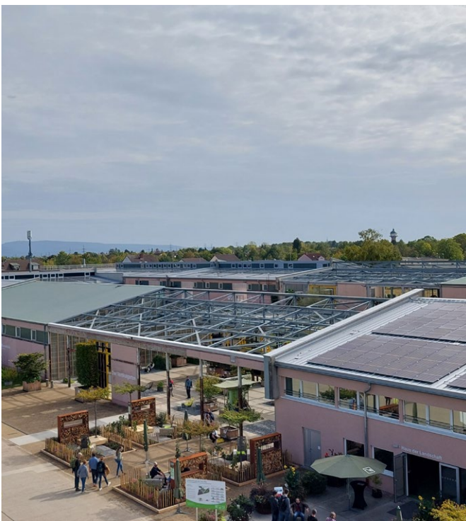
Abb. 43: Teilabbruch Gebäude zugunsten Kaltluftströmung, Mannheim
