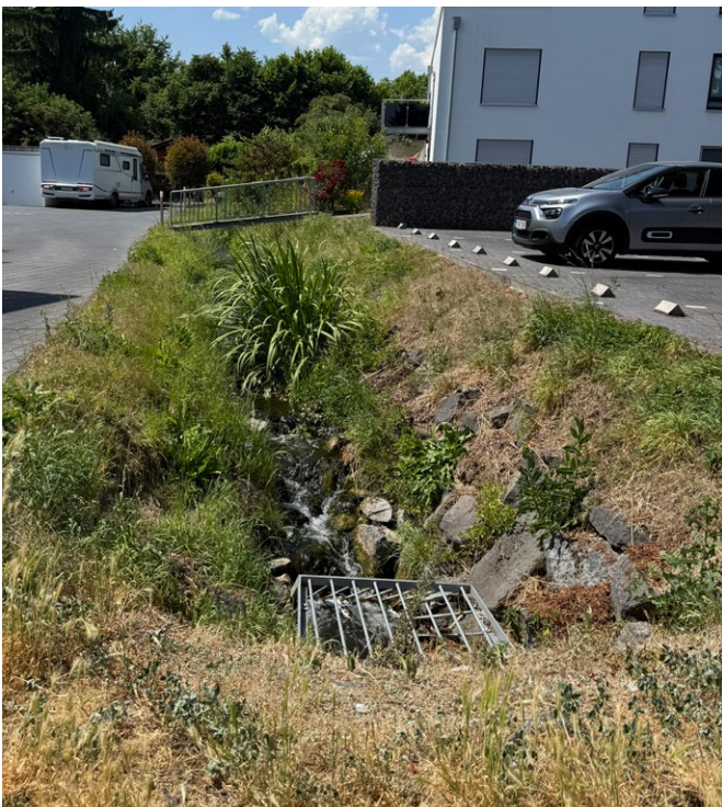
Abb. 55: Renaturierung des Gewässerbereichs, Mendig
