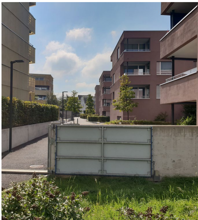
Abb. 66: Baulicher Überflutungsschutz Wohnhäuser, Zürich
