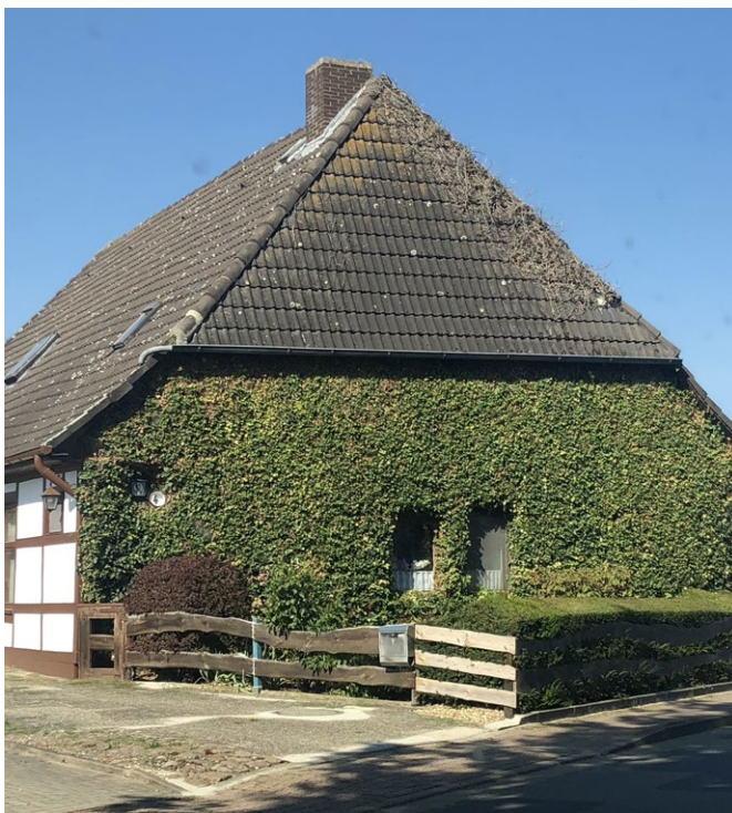
Abb. 61: Fassadenbegrünung an einem Wohnhaus, Ribbesbüttel
