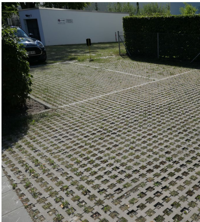
Abb. 48: Teilentsiegelung eines Parkplatzes, Freising
