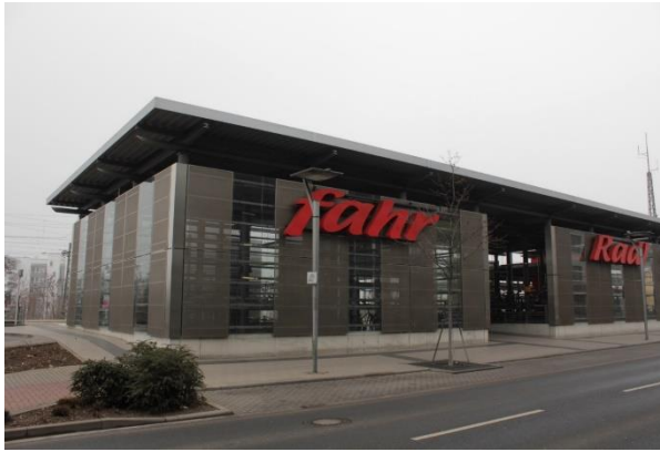
Abbildung 11: Das Fahrradparkhaus in Ingelheim von außen (eigene Aufnahme)
