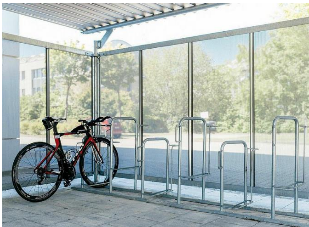
Abbildung 7: Überdachte Radabstellanlage: Gronard: Kappa (ADFC o. J. a)
