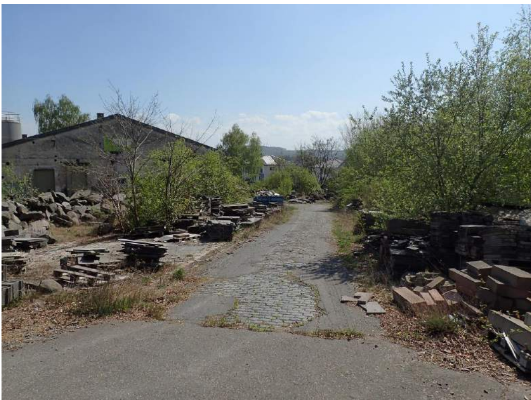
Bild 20: Versiegelter Zufahrtsweg auf dem Grundstück 'SHS Naturstein' mit den randlich gelegenen Lagerflächen und zunehmend verbuschten Bereichen
