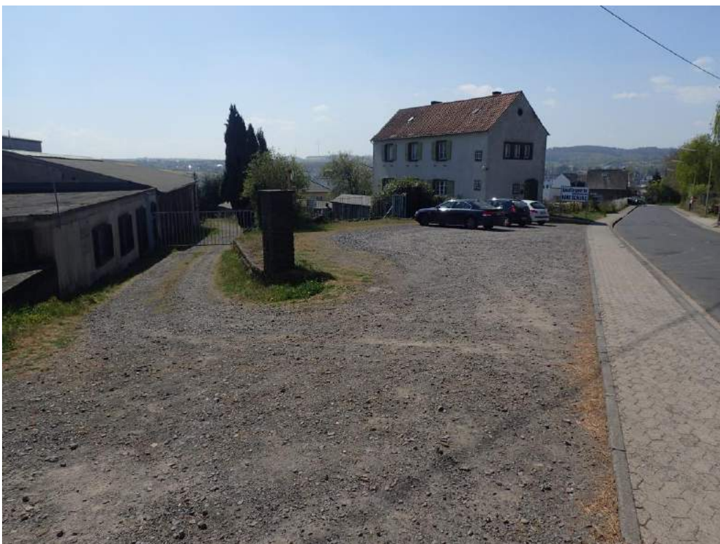
Bild 02: Blick auf das Betriebsgelände der Basaltlavawerke Hans Schlink KG
