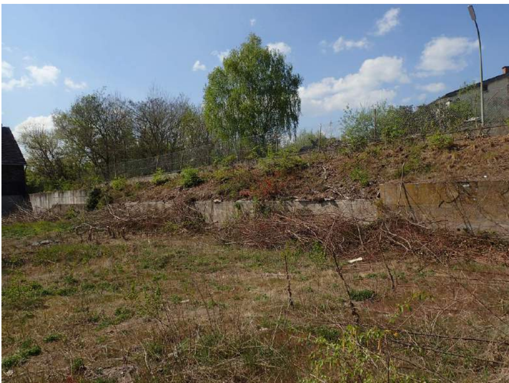
Bild 26: Mauer- und Böschungsabschnitte am Nordrand von Parzelle 435/36 (Gem. Mayen, Flur 22)
