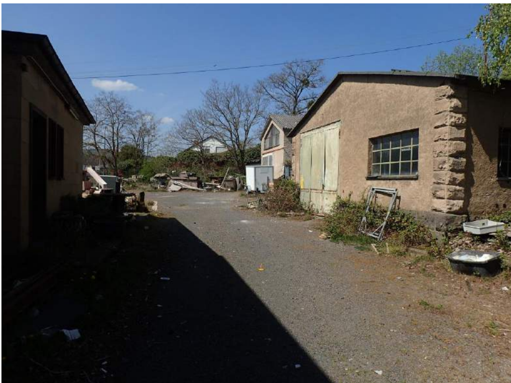
Bild 18: Blick auf den nördlichen Teil des Grundstücks 'SHS Naturstein' mit Gebäudestrukturen und zahlreichen Ablagerungen
