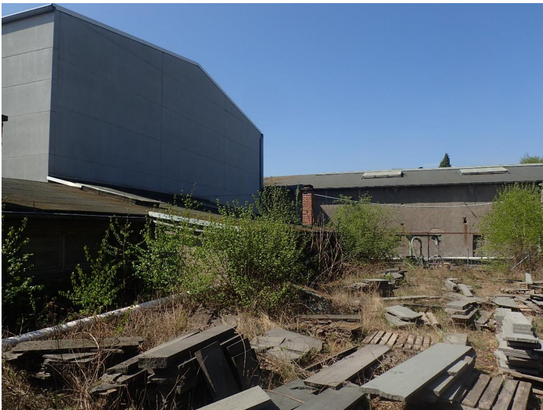
Bild 22: Rückansicht der Gebäude im südlichen Abschnitt
