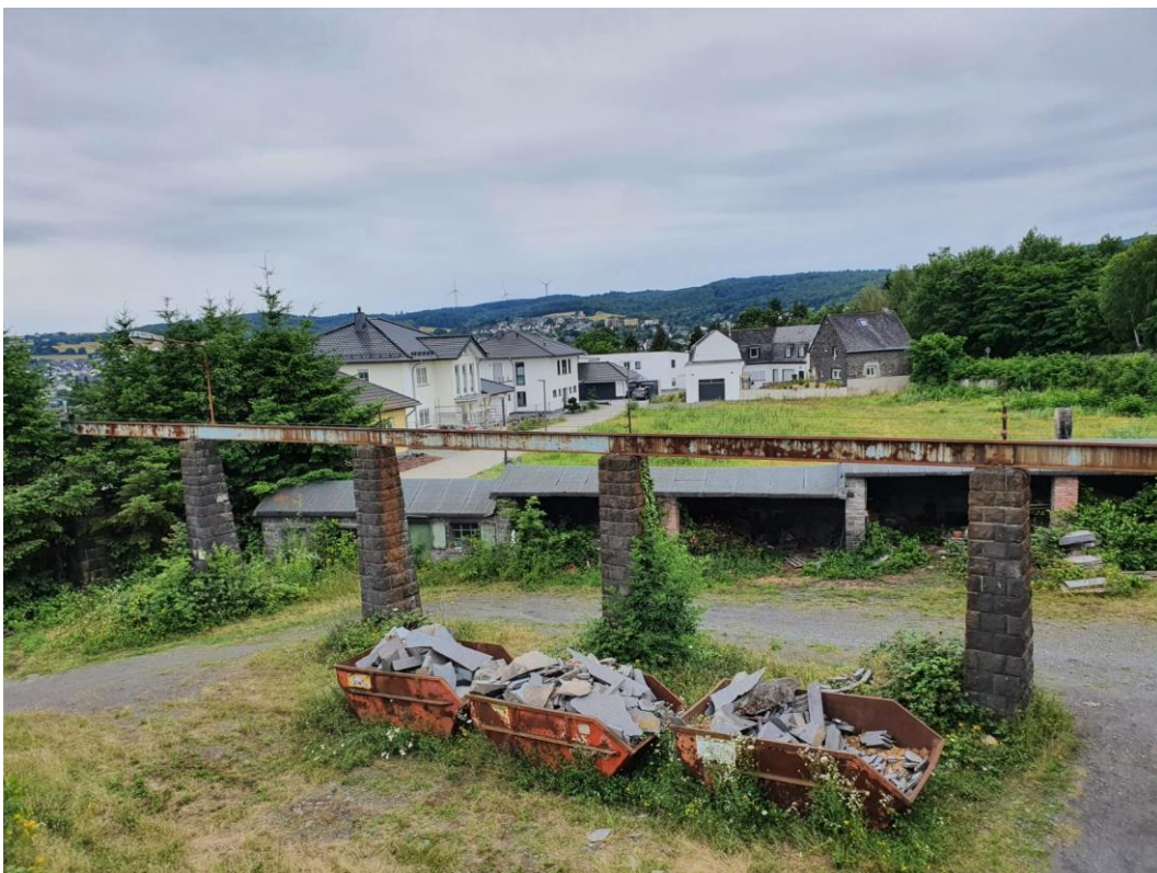
Bild 18: Die alten Schienen des Krans bieten den Vögeln gute Anblicksmöglichkeiten (vom Hubsteiger aus)
