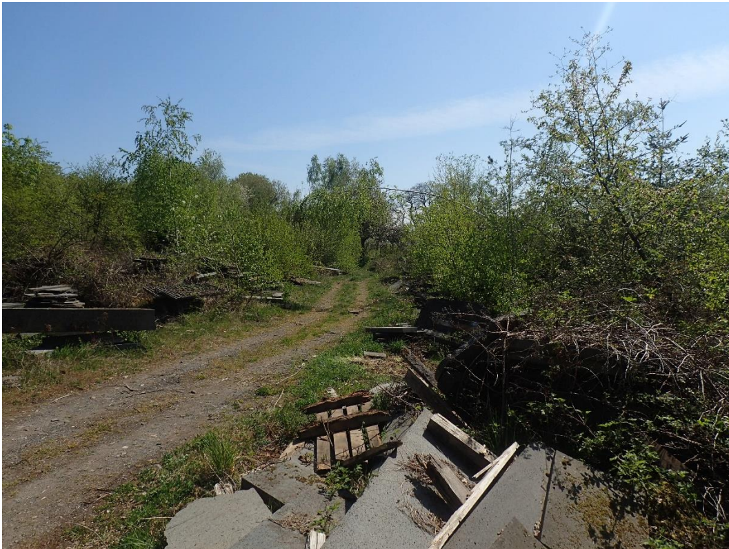
Bild 25: Blick auf den östlichen Teil des südöstlichen Betriebsgeländes
