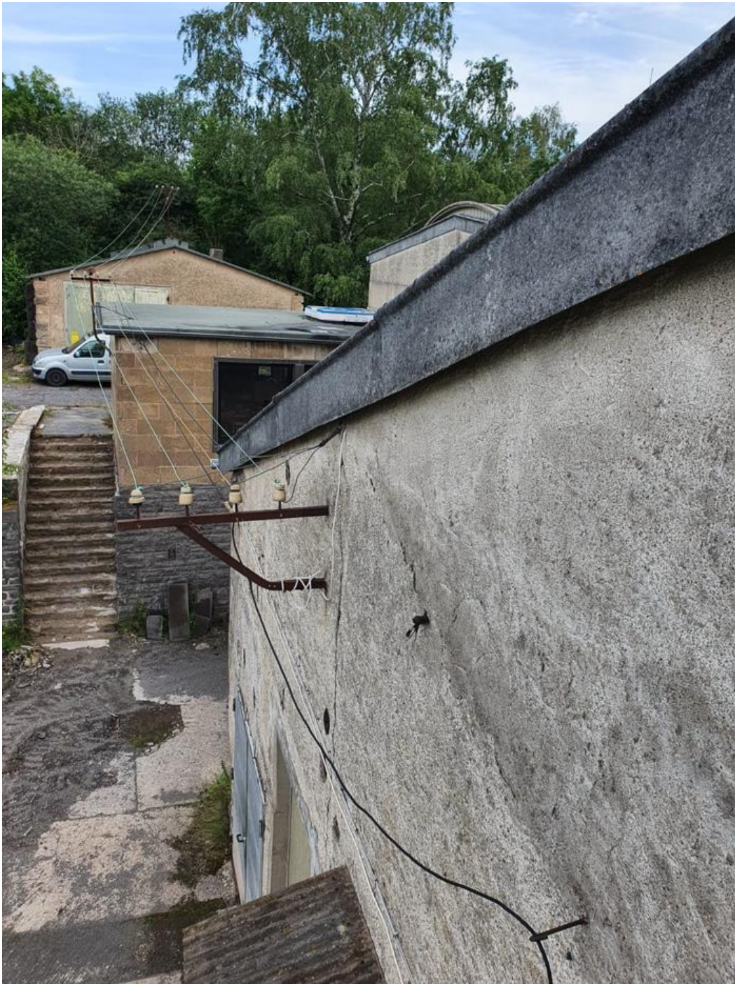
Bild 33: Mittels Hubsteiger konnten die meisten potenziellen Fledermausquartiere gezielt auf eine tatsächliche Nutzung überprüft werden
