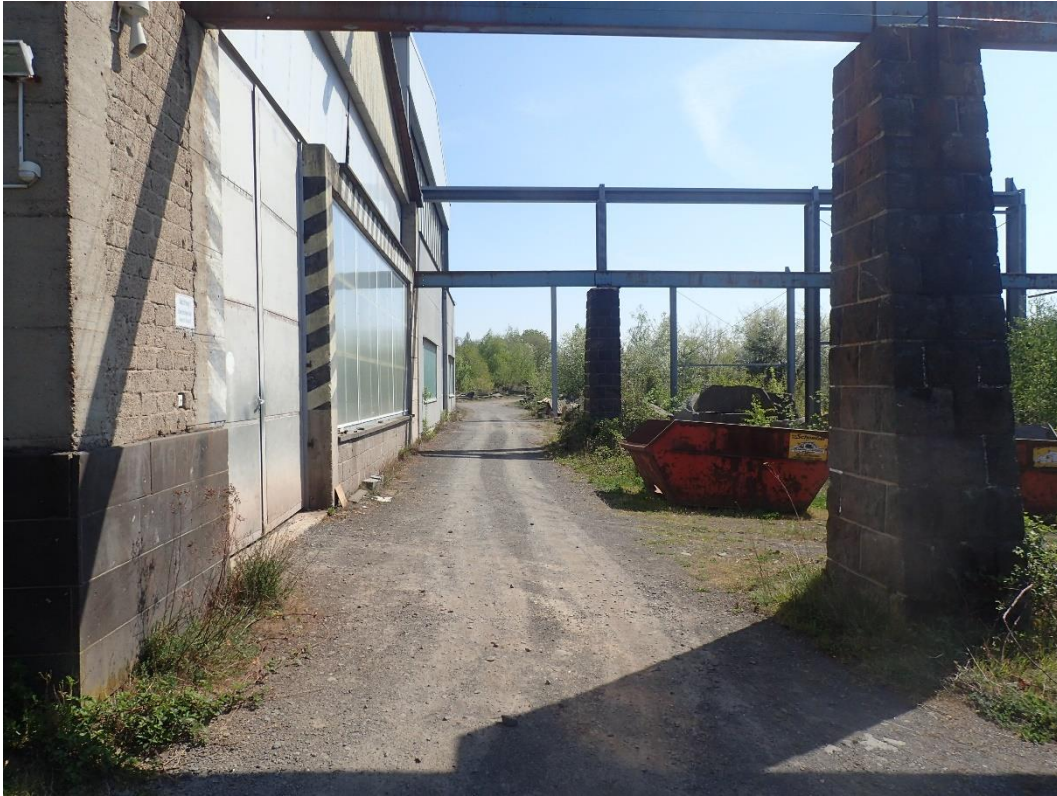
Bild 17: Blick entlang der Betriebshalle im Südosten
