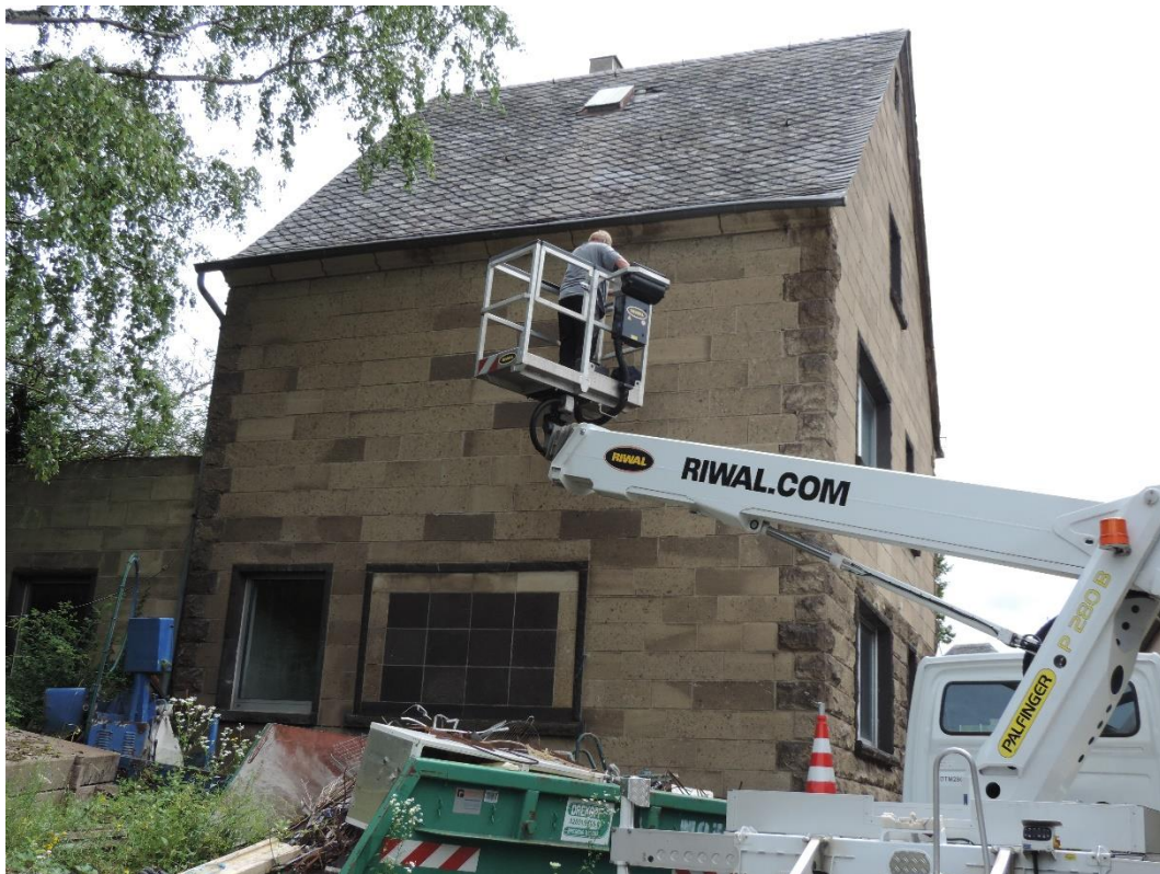
Bild 31: Mit einem Hubsteiger wurden alle Gebäude nach Fledermausquartieren abgesucht
