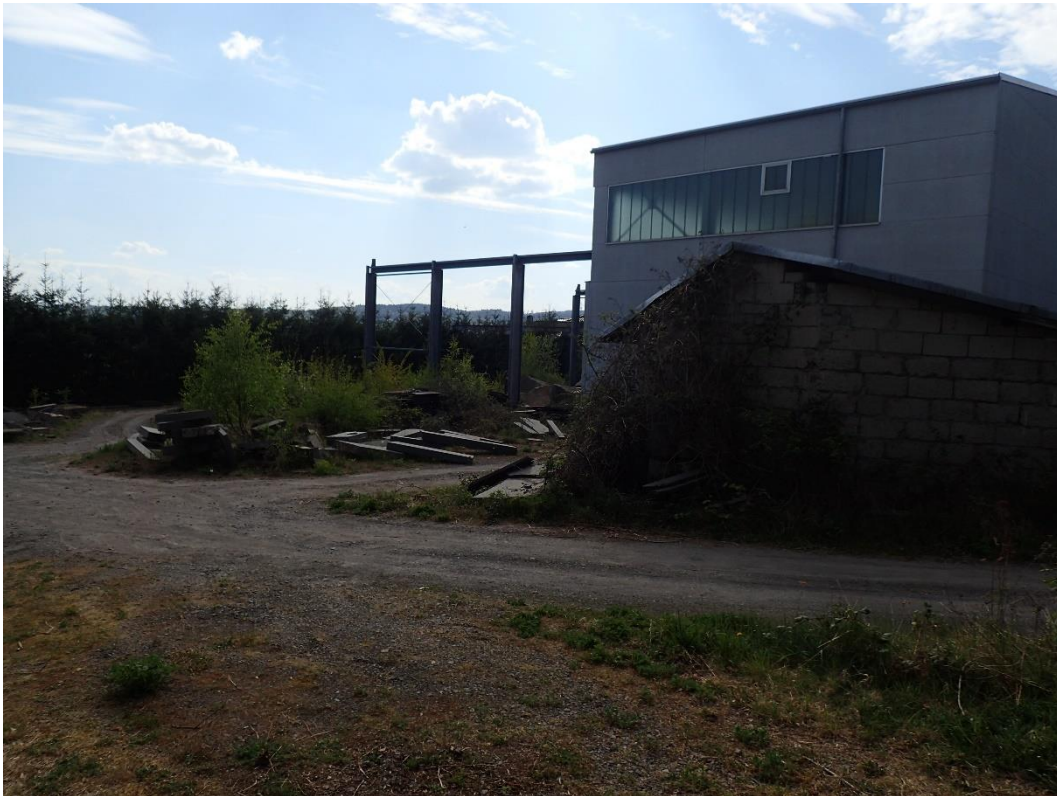
Bild 23: Blick auf die Ostseite des Gewerbegebäudes
