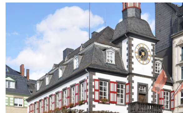
Abb. 65 Beim historischen Rathaus sind Seitenwangen und Dächer der Gauben im gleichen Material gedeckt wie die Dachflächen. Die Dachlandschaft erscheint dadurch als gestalterische Einheit. Foto: Johannes Buchhammer, Oktober 2024
