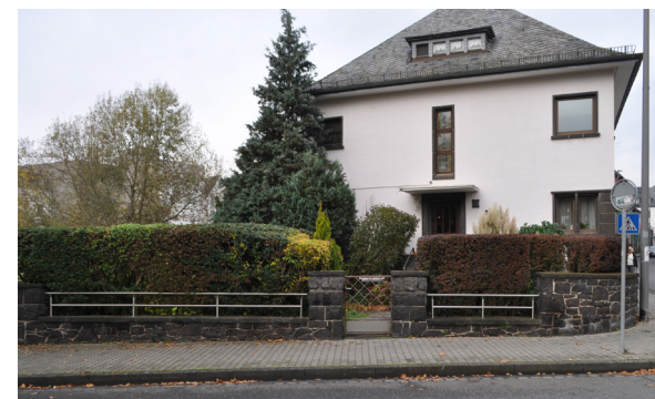
Abb. 123 Gestalterische Einheit aus Einfriedung und Gebäudearchitektur bei einem Wohnhaus in der Straße Im Trinnel in Mayen. Die Einfriedung besteht aus einem aus Basaltlava gemauerten Sockel und handwerklich gefertigten bekrönenden Gittern aus weiß lackiertem Stahl sowie dahinter gepflanzten Hecken. Basaltlava und Dachschiefer binden die Gesamtanlage optisch zusammen. Foto: Johannes Buchhammer, Oktober 2024
