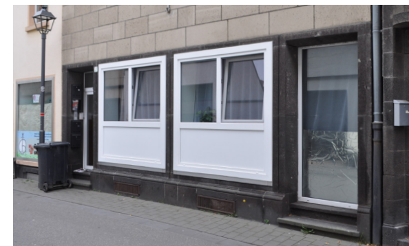
Abb. 51 Hier wurde das Erdgeschoss zu Wohnzwecken umgenutzt. Um dem Bedürfnis nach Privatsphäre gerecht zu werden, wurden neue Fenster mit Brüstungen eingesetzt. Eine massiv gemauerte Brüstung aus Basaltlava hätte sich in die hochwertige Naturstein-Fassade besser eingefügt. Die frühere Laden-Eingangstür ist mit Spiegelfolie bis in Brüstungshöhe abgeklebt, was auf Dauer keine ansprechende Lösung darstellt. Foto: Johannes Buchhammer, Oktober 2024
