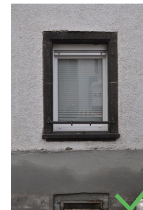
Abb. 98 Rollladenkasten fassadenbündig eingebaut
