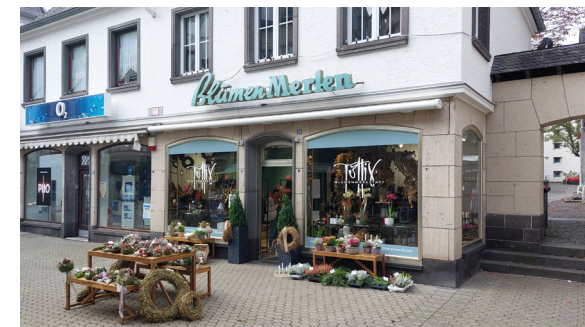
Abb. 47 Die Warenauslagen ordnen sich der Fassadengestaltung unter und treten nicht in Konkurrenz zu den Schaufenstern. Foto: Johannes Buchhammer, Oktober 2024
