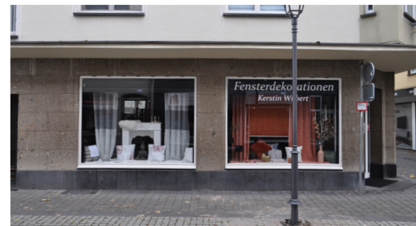
Abb. 101 Schaufenster in einem Gebäude der Nachkriegs-Wiederaufbauarchitektur mit Mayen-typischer Materialität: Sockel aus Basaltlava, Fassaden aus Weiberner Tuff, weiße Fensterrahmen. Mayen, Göbelstraße. Foto: Johannes Buchhammer, Oktober 2024
