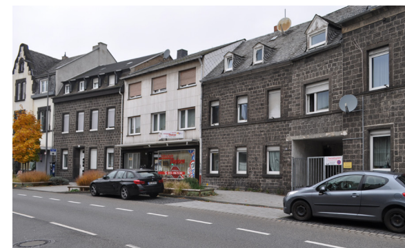
Abb. 20 Geschlossene Altbau-Ensembles sind selten, häufig wechseln Gebäude unterschiedlicher Erbauungszeit einander ab, hier eine Szenerie am Habsburgerring. Trotz unterschiedlichen Alters harmonisieren die Gebäude: Die einheitliche Dachgestaltung in Schiefer und Fenstergewände aus Basaltlava sorgen für eine Verbindung. Die Erdgeschosszone des Nachkriegsgebäudes stellt mit dem dunklen Naturstein eine Beziehung zur angrenzenden Bebauung her. Foto: Johannes Buchhammer, Oktober 2024
