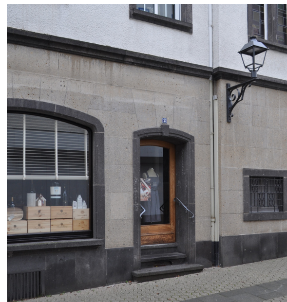
Abb. 113 Typische Mayener Fassadenmaterialität: Sockel und Gesims aus Basaltlava, die Erdgeschosszone in Tuffstein verkleidet. Alle Tür- und Fenstereinfassungen sind aus Basaltlava und aufwändig steinmetzmäßig bearbeitet. Die Fassadenflächen in den oberen Geschossen sind weiß verputzt und weiß gestrichen. Foto: Johannes Buchhammer, Oktober 2024
