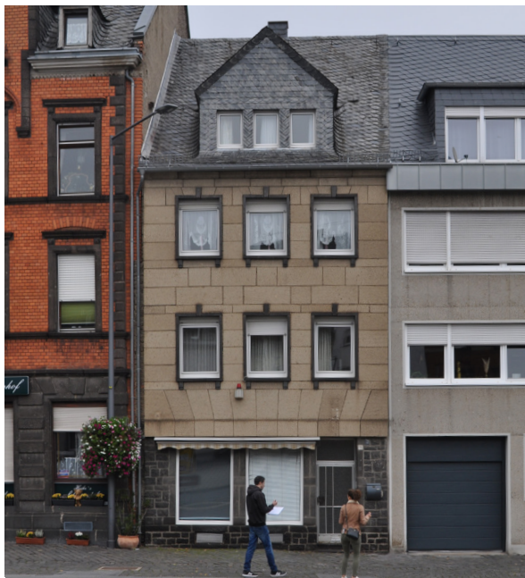
Abb. 21 Typische Fassadenmaterialien in Mayen: Basaltlava (Erdgeschoss + Fenstergewände), Tuff (Obergeschosse), Schiefer (Dach) Foto: Johannes Buchhammer, Oktober 2024
