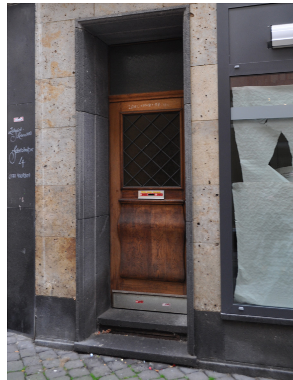
Abb. 109 Türanlage der Nachkriegszeit in der Mayener Innenstadt, bestehend aus einer hölzernen Tür mit Glasausschnitt und Gitter sowie einem Oberlicht. Foto: Johannes Buchhammer, Oktober 2024
