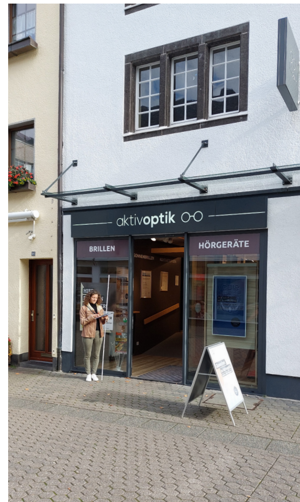
Abb. 82 Ein Vordach als Glas-Metallkonstruktion in der Marktstraße Foto: Johannes Buchhammer, Oktober 2024
