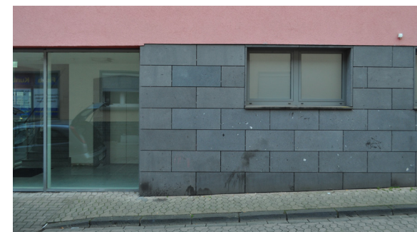
Abb. 114 Moderne Adaption typischer Mayener Materialien: Basaltlava-Platten als vorgehängte Fassade im Bereich des Erdgeschosses bei einem Bürogebäude. Fassade in der Straße Bornhaustert/Ecke Töpferstraße, Mayen. Foto: Johannes Buchhammer, Oktober 2024
