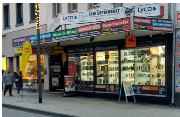
Abb. 38 Die Vielzahl Schriftzüge verschiedener Marken wirkt auf den Betrachter überfordernd und schwächt letztlich die Wirkung der einzelnen Botschaft. Die Werbung verdeckt Vordach und Fassade, vom Gebäude selbst ist wenig wahrzunehmen. Foto: Johannes Buchhammer, Dezember 2025
