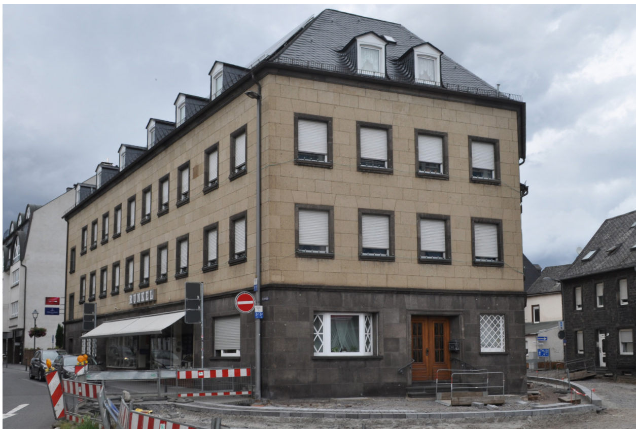
Abb. 12 Haus Runkel, Neustraße. Typischer „Material-Kanon“ der Mayener Nachkriegsarchitektur: Sockelzone in Basaltlava, Fassade in den Obergeschossen in Tuff, Dacheindeckung in Naturschiefer. Foto: Johannes Buchhammer, Oktober 2024
