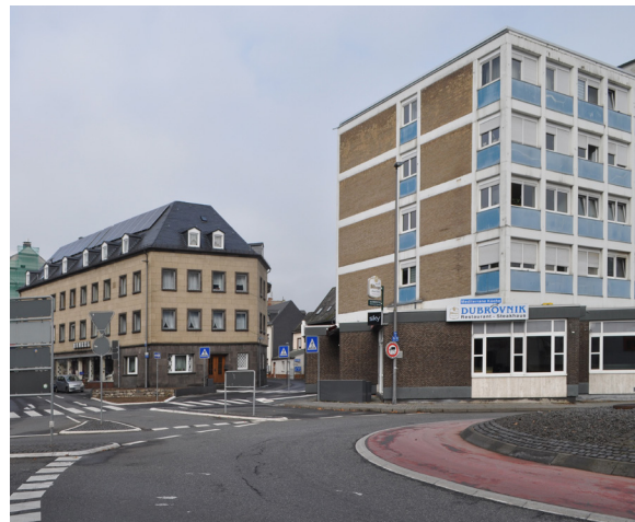
Abb. 10 Im Bereich des ehemaligen Neutors entstand in der frühen Nachkriegszeit das Haus Runkel (links) als gut eingepasster Neubau in den typischen Mayener Materialien: das Dach aus Naturschiefer, die Wandflächen aus Tuffstein, das Sockelgeschoss und die Fenstereinfassungen aus Basaltlava. Der Neubau aus den 1960er Jahren (rechts) nimmt hingegen weder in seiner Höhenentwicklung noch in der Materialität Bezug auf die Stadt und erscheint als Fremdkörper. Als Höhendominante ausgebildet, wollte der Architekt hier wohl ein „Tor zur Altstadt“ schaffen, was ohne Gegenüber aber misslang. Foto: Johannes Buchhammer, Oktober 2024
