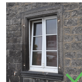
Abb. 91 Denkmalsprossen, historisch korrekt zweiflügelig, mittlerer echter Pfosten, insgesamt stimmiges Bild
