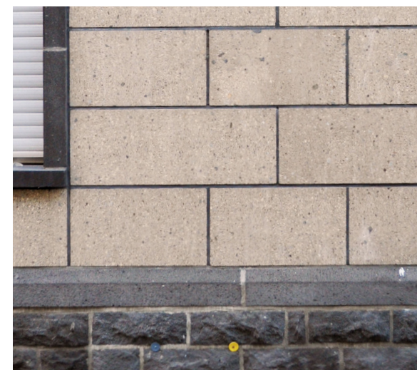
Abb. 115 Sockel und Fenstereinfassungen aus Basaltlava, Fassadenflächen aus Tuffstein, Fugen jeweils kontrastierend zum umgebenden Naturstein Foto: Johannes Buchhammer, Oktober 2024
