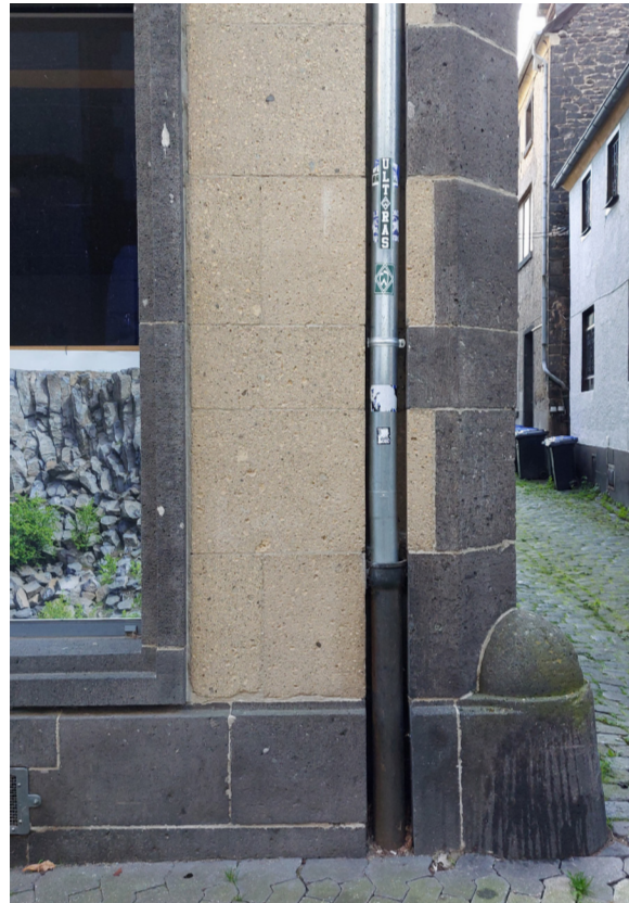
Abb. 27 Präzise Durcharbeitung bis ins Detail: Wiederaufbauarchitektur in der Brückenstraße. Die Fallrohre sind in eine Nische fassadenbündig eingesetzt, die Außenecke des Basaltlava-Sockels ist mit einem Prallstein akzentuiert und zugleich geschützt. Die Mauerwerksfugen sind farblich an die Tuffsteinflächen angeglichen, wodurch sich ein reizvoller Kontrast zu den dunklen Basaltlavasteinen ergibt. Das Straßenpflaster besteht ebenfalls aus Basaltlava, wodurch sich eine Verbindung zum Gebäudesockel ergibt. Foto: Johannes Buchhammer, Oktober 2024
