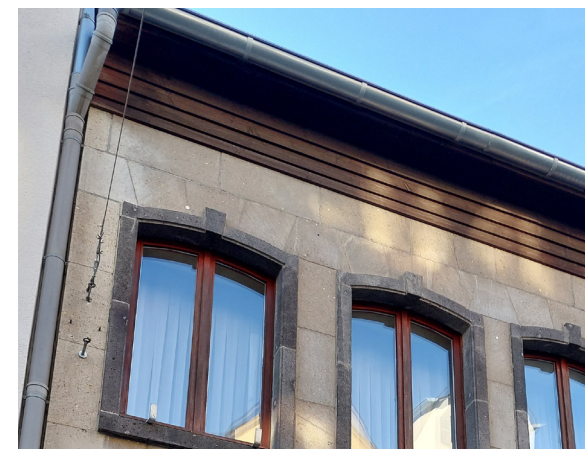
Abb. 24 Traufgesims als Holzverkleidung an einem Gebäude der Wiederaufbauzeit am Brückentor. Foto: Johannes Buchhammer, Oktober 2024
