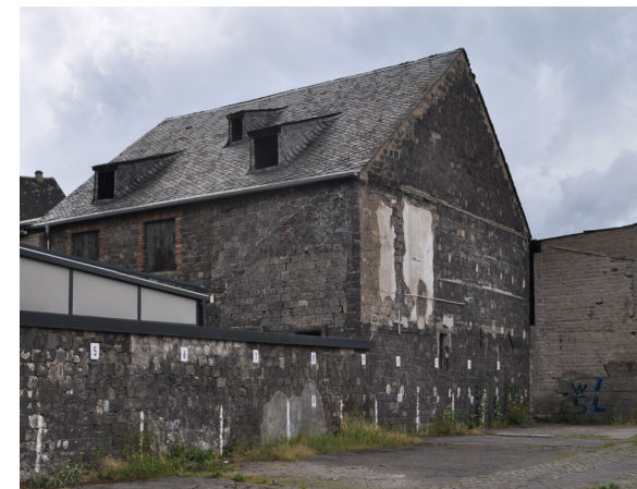
Abb. 57 Charakteristische geringe Dachüberstände an Traufe und Ortgang bei einem historischen Altstadt-Gebäude im Mühlenweg 17. Foto: Johannes Buchhammer, Oktober 2024
