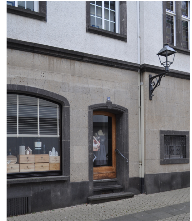
Abb. 17 Sockel und Gesims aus Basaltlava rahmen die mit Tuffstein verkleidete Erdgeschosszone. Die Tür- und Fenstergewände aus Basaltlava sind aufwändig steinmetzmäßig bearbeitet. Die Obergeschosse sind verputzt ausgeführt. Der mutmaßlich ursprünglich nicht farbig gefasste Putz wurde nachträglich weiß gestrichen. Foto: Johannes Buchhammer, Oktober 2024
