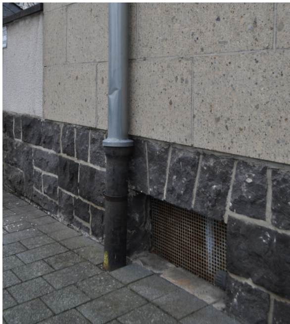
Abb. 26 Der Übergang zwischen dem dunklen gusseisernen Standrohr und hellerem dachdeckermäßigen Fallrohr aus Titanzink ist präzise auf den Gebäudesockel aus Basaltlava bezogen. Foto: Johannes Buchhammer, Oktober 2024
