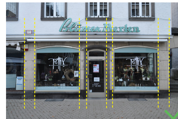
Abb. 87 Gliederung der Erdgeschosses durch Pfeiler Foto: Johannes Buchhammer, Oktober 2024
