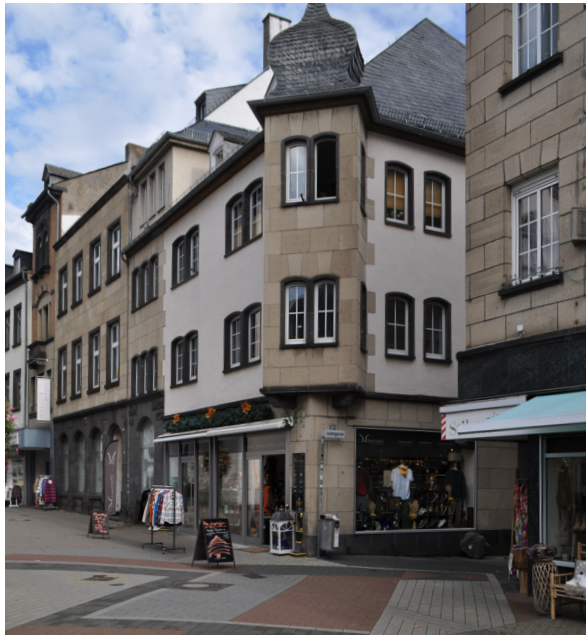
Abb. 15 Ensemble der Wiederaufbauarchitektur an der Marktstraße Ecke Judengasse: Verbindlicher Material-Kanon aus Basaltlava, Tuff, Putz und Naturschiefer, differenzierte und detailreiche architektonische Umsetzung mit Erkern, Turmhaube, Gesimsen und verschiedenen Fensterformaten Foto: Johannes Buchhammer, Oktober 2024
