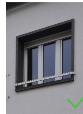
Abb. 99 Klassisches Mayener Farbschema: Weiße Fensterrahmen, dunkle Fenstereinfassungen, im Kontrast zu weiß verputzte Fassaden.
