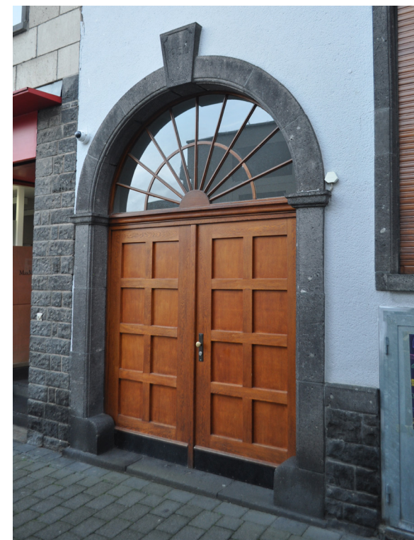
Abb. 110 Aufwändige Türanlage der Nachkriegszeit in der Mayener Innenstadt, bestehend aus einer hölzernen Tür mit Kassetierung sowie einem Oberlicht. Kirchgasse, Mayen. Foto: Johannes Buchhammer, Oktober 2024
